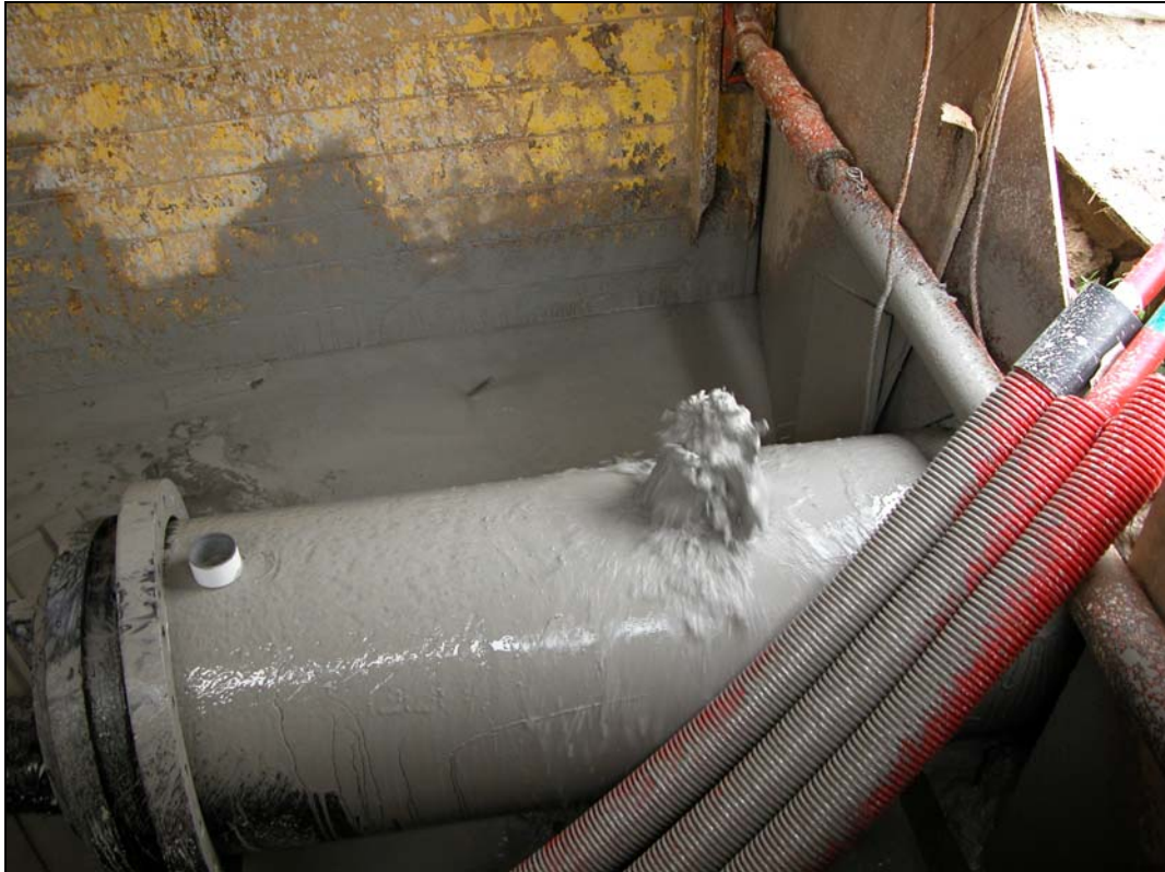
Abb.3: Überlaufstutzen am Hochpunkt des Hüllrohres (Quelle: De Keerkring BV).
