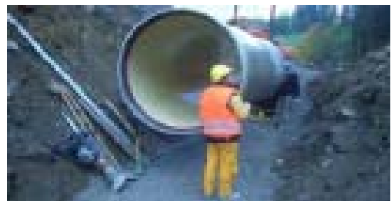
Abb. 3: GFK-Rohrkanal nach [4] zur Aufnahme von zwei Kabelsystemen Innendurchmesser 2.7 m
