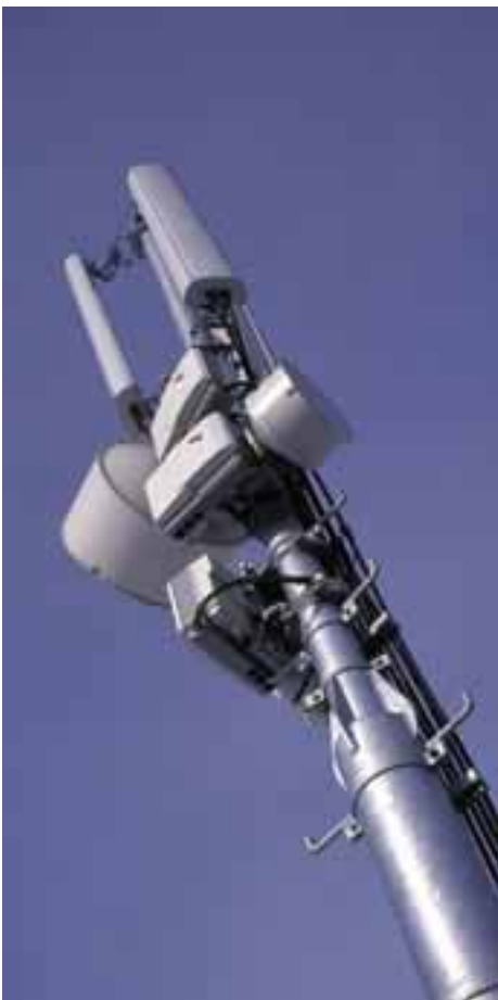
Mast mit Mobilfunkantennen (zuoberst) und Richtfunkantennen (rund). Letztere verbinden die Basisstationen mit den Telefonzentralen.
